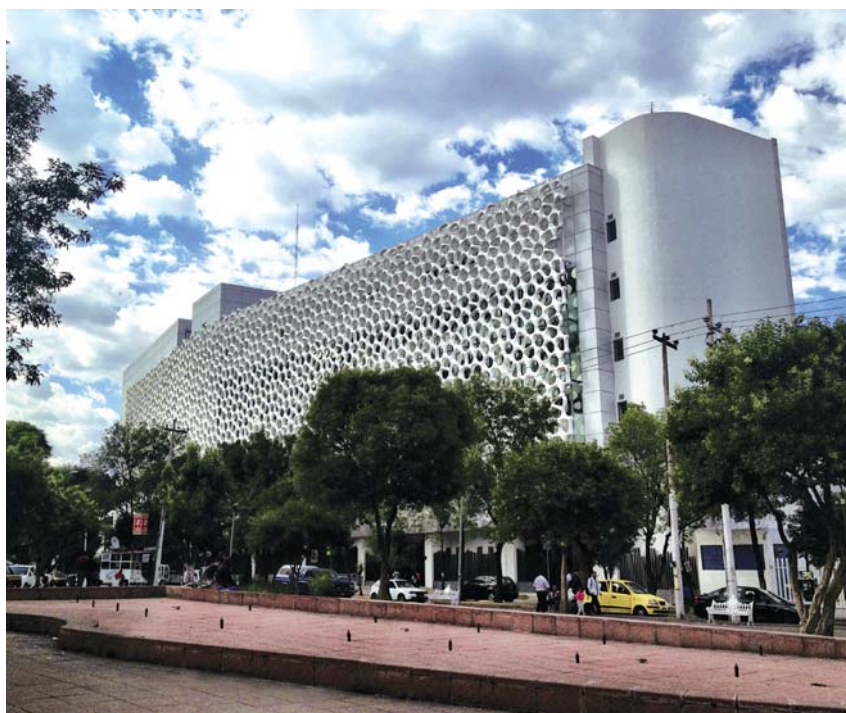
Fachada Torre nueva Hospital Gea González.
